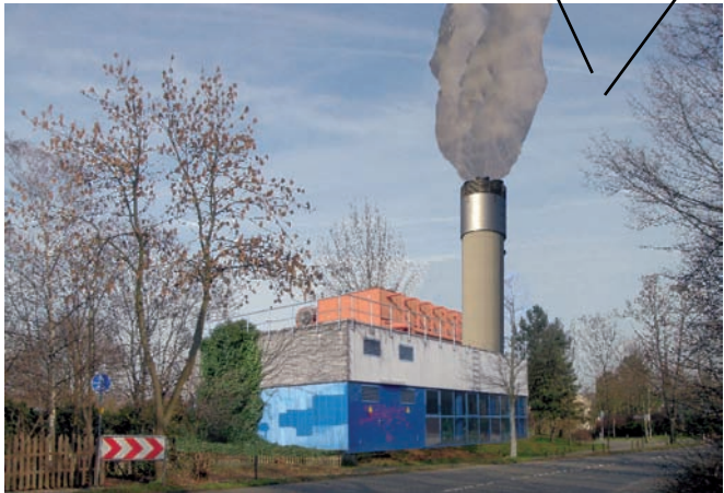
Problem Kamin ohne Filter?
