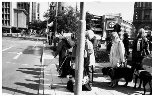
Bordsteinhöhe und Art und Lage der Rippenplatten werden systematisch untersucht. Hier steht der Ampelmast falsch, weil am Rand.
